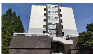
■ 文教育学部1号館（I期）改修工事
